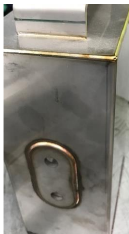
ステンレス溶接(仕上げ前)
